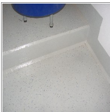
Kellerräume und Werkstätten:
